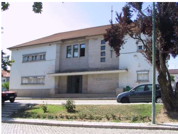
Edifício propriedade do Ministério da Justiça
