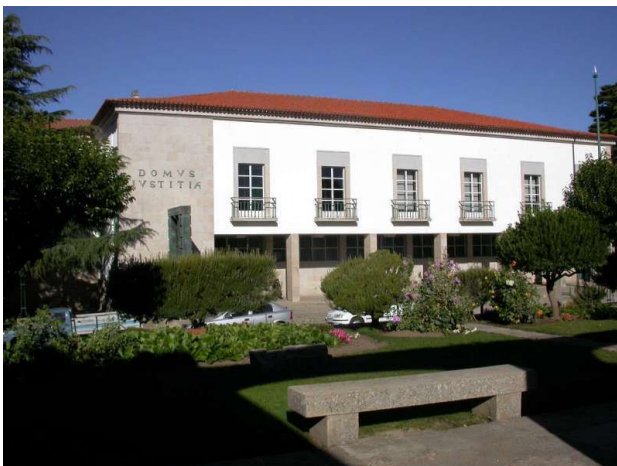
Edifício propriedade do Ministério da Justiça
