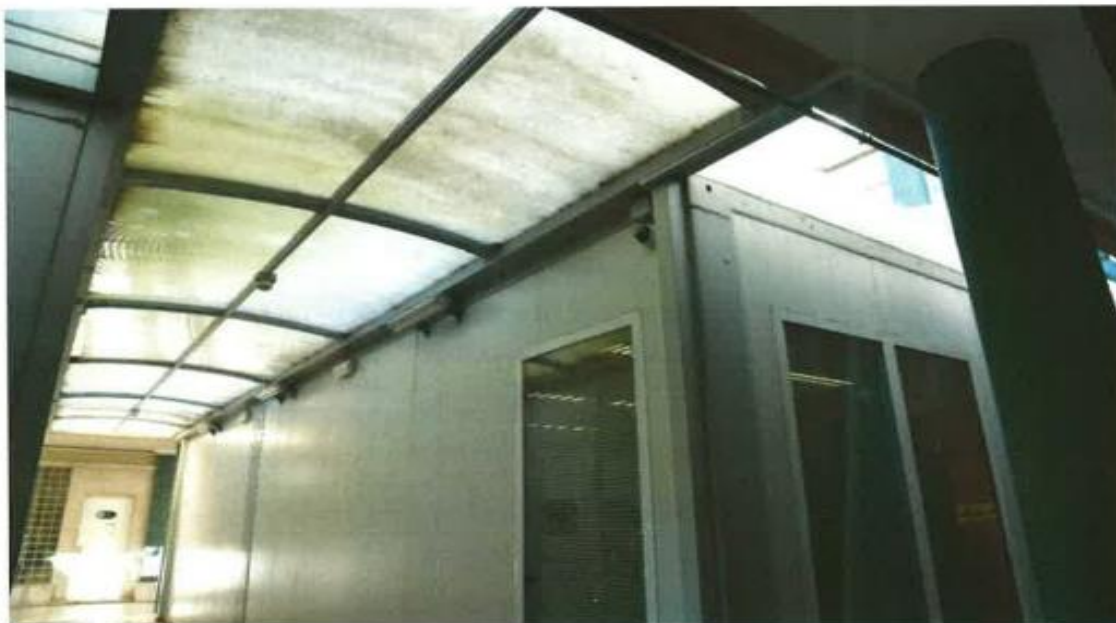
Vista exterior do módulo onde funciona a Secção Central, Palácio Justiça Vila Franca de Xira
