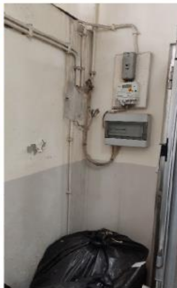
Arrumo exterior - Cablagens e quadro elétrico com instalação inacabada
