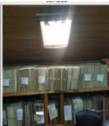
Sotão / arquivo - Janela de sótão de boa qualidade mas integrada em cobertura com deficiente isolamento e impermeabilização como demonstra a ondulação do forro
