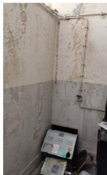
Arrumo exterior - Reboco e pintura que evidencia um histórico de infiltrações
