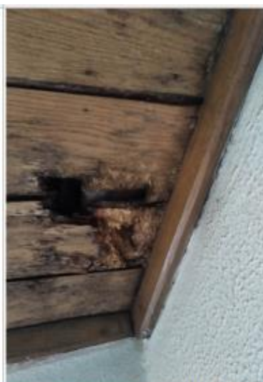
Escadas de acesso ao arquivo - Forro danificado expondo falta de isolamento e impermeabilização do telhado
