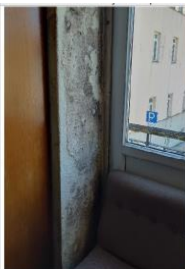
Antecâmara da sala de audiências - Insalubridade associada a fungos e líquenes originados por infiltrações
