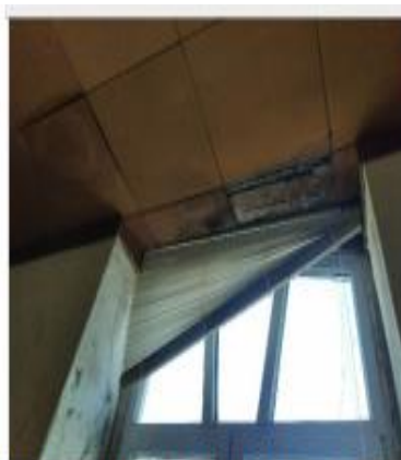
Antecâmara da sala de audiências - Infiltrações no teto e ombreiras. Caixilharias datadas, com falhas de isolamento perimetral e estores com mecanismo ineficiente
