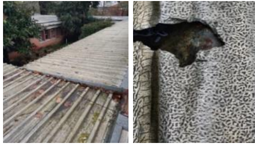
Pormenores da cobertura do Palácio da Justiça de Rio Maior
